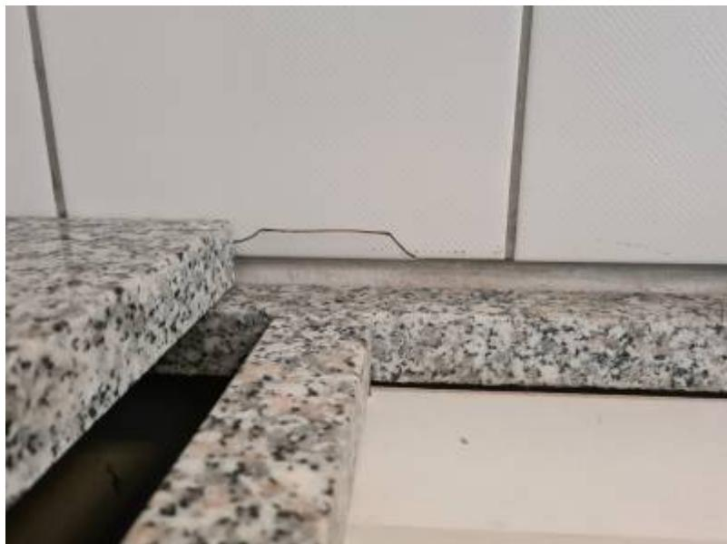
**Es wurde eine Lösung gefunden. Ersatz-, oder neue Kacheln gab es nicht mehr.** Ein neuer Fliesenpiegel würde das Projekt „Neu Küche“ sprengen. So wurde eine Streifen Unterkonstruktion angefertigt und verbaut,
